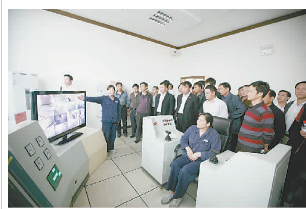
9 月 25 日上午,来自全省煤炭行业总工程师培训班的 61 名学员,在河南理工大学的组织下,到赵固二矿进行了实地参观学习。他们对该矿的管理制度标准化、人员配备标准化、现场管理标准化和过程控制标准化等现代化管理手段表示赞赏。图为他们在参观该矿现代化的主井绞车房。
