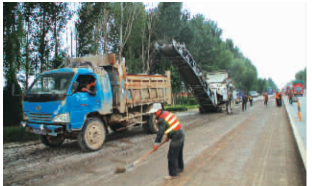
图为获轶线改造工程施工现场。
