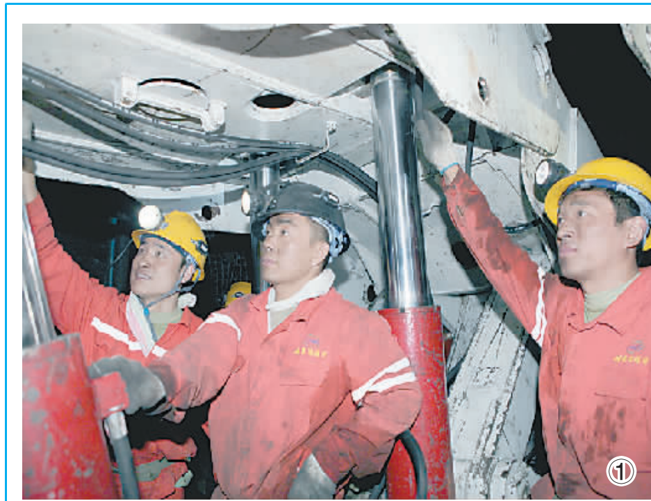
图① 近日,新疆豫焦能源有限公司为寻求解决适合当地的急倾斜煤层开采方法,经过充分调研论证,按照多上设备、少上人的机械化发展思路,新上了一套综采设备,为急倾斜煤层采用综采放顶煤开采技术进行了有益尝试。韩献华 摄
