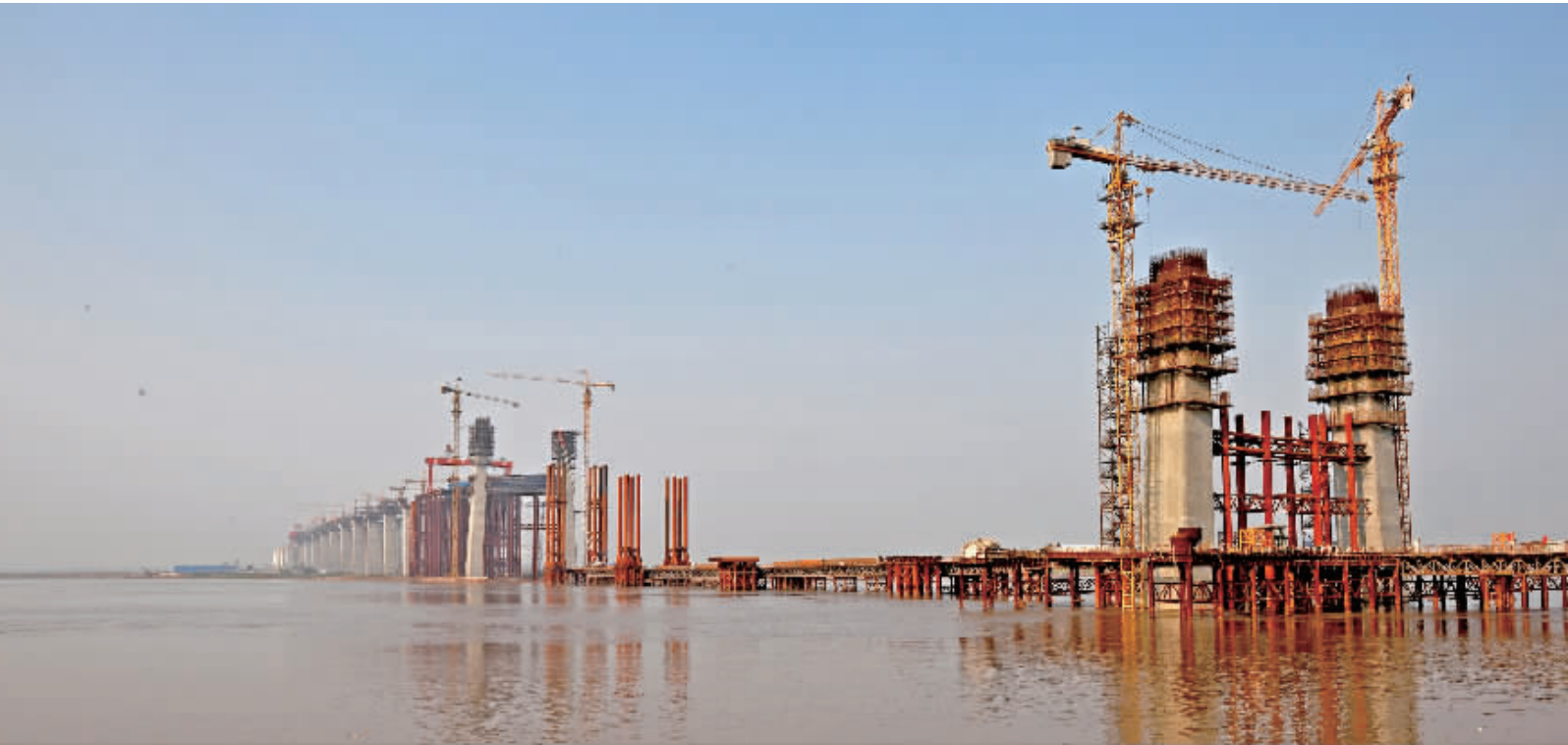
国庆节期间,中国中铁大桥局集团一公司广大建设者放弃休息时间,日夜奋战在工作岗位上,南北主塔向 70 米高空攀升,北副桥、南引桥施工秩序井然,一派繁忙景象,他们以大干快上、保安全、保质量、展形象的实际行动向国庆献礼! 图为 10 月 6 日下午,正在建设中的武西高速公路桃花峪黄河大桥主塔。本报记者 张德斌 通讯员 孙东勋 摄
