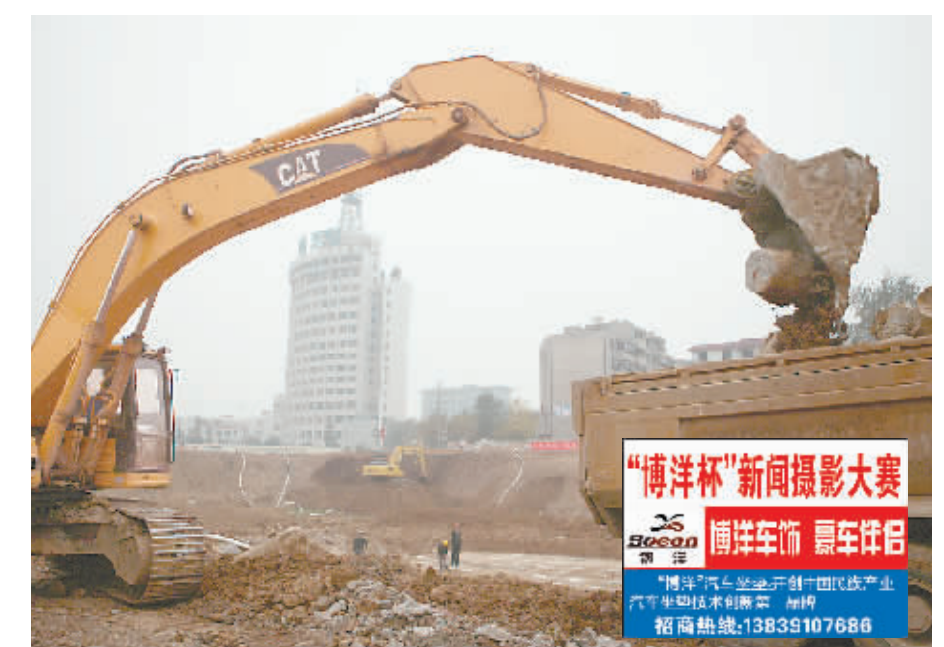
昨日,建设者正在南水北调中线焦作城区段塔南路倒虹吸工程东倒虹吸出口进行基础清理施工。自九月中旬塔南路倒虹吸工程已开挖土方七万五千方米,完成塔南路主干道可恢复至正常通行。该工程预计今年年底建成,届时塔南路主干道可恢复至正常通行。本报记者 赵耀东 摄
