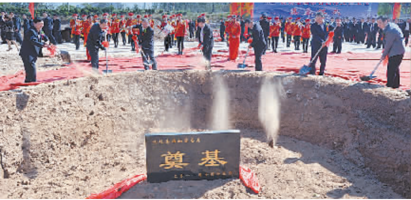
图为参加奠基仪式的领导为物资总库迁建项目工程奠基。 杨文豪 摄
