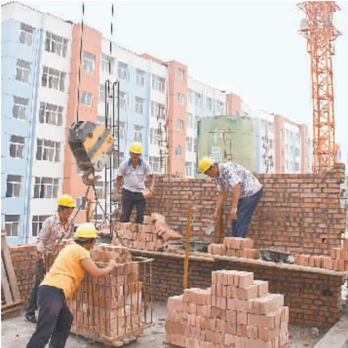
昨日,工人们正在修武县惠民小区加快建设经济适用房。据了解,该项目占地0.8亩,总投资1417万元,共建设5栋居民楼11841.68平方米,项目建成后可解决124户低收入家庭的住房困难。
