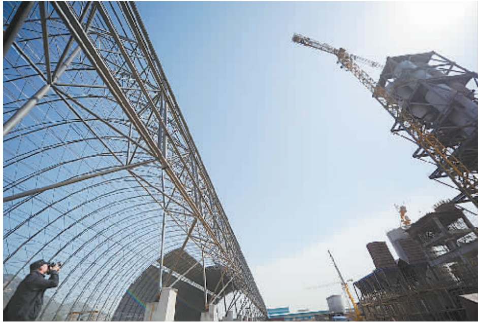
10 月 22 日，沁阳市年产 100 万吨电石渣制水泥项目工地，工人们正在吊装建设材料。该项目总投资 5 亿元，以化工废弃物电石渣为原料，实现了电石渣的循环利用。项目完全达产后，年可消耗电石渣废料 113 万吨，实现销售收入 3 亿元。 李亚锋 摄
