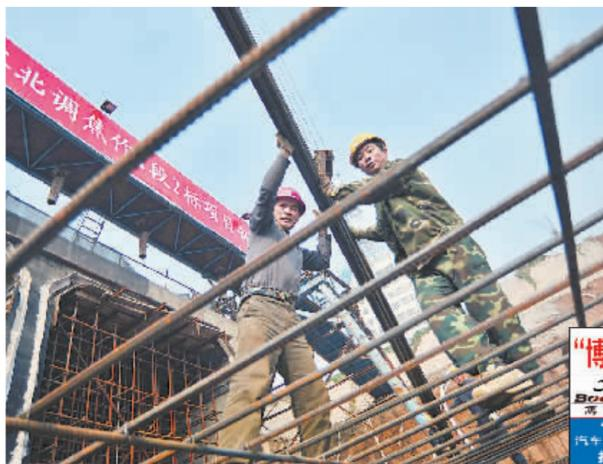
昨日上午,在南水北调中线工程焦作1段II标段倒虹吸工程施工处,建设者正在为倒虹吸管身段吊装钢筋。该建筑物总长441米,横跨塔南路。目前一期工程基本完工,二期工程已全面展开。
