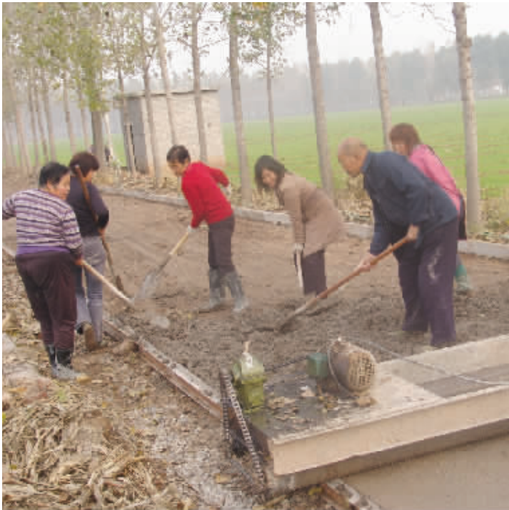
初冬时节,寒气渐浓,为加快工程项目建设,圆满完成工程任务,我市柏香土地整理项目区呈现出一幅繁忙施工的景象。图为施工人员正在硬化道路。 崔伍 摄
