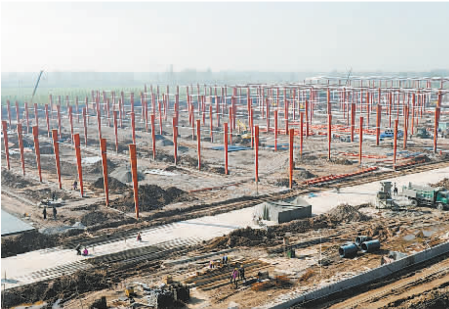
11月18日,河南超威电源公司年产1100万只电动自行车用蓄电池项目建设现场,施工工人正在紧张施工。据悉,该项目是河南超威电源公司第三期扩建项目,项目总投资10亿元,预计2012年5月份建成投产。届时,该公司年产值将达到35亿元,创利税7亿元,安排就业岗位5000个。 李亚锋 摄
