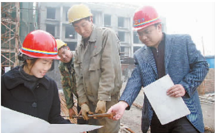
日前,解放区审计局审计工作人员正在南水北调王褚街道西于村安置小区检查建筑材料。今年年初以来,为加强对南水北调安置小区工程的审计监督,解放区审计局制定了《解放区南水北调中线建设项目跟踪审计操作办法》,全过程参与监督了该区7个行政村共50栋安置楼的招标过程,并全程跟踪审计,全力服务好南水北调建设。李良贵 摄
