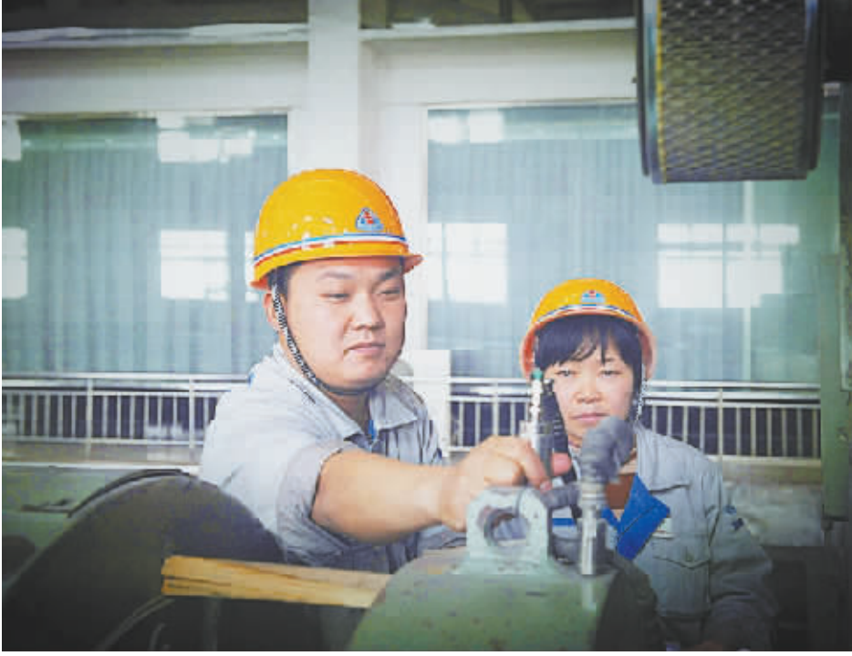
11月份以来,面对供电紧张的局面,河南煤化焦煤集团冯营电力公司不断加强机组安全运行管理,做到设备问题早发现、早处理,为机组满发电、多供电奠定了基础。图为工作人员正在监控设备运行情况。 夏彬彬 摄
