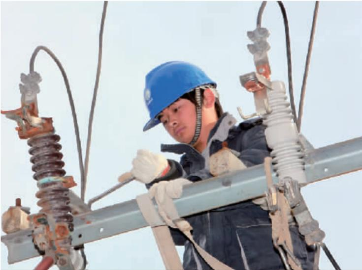
连日来,县电业局投入2万余元,对城区内30个配电台区老化的跌落式熔断器进行改造,更换为新型的喷射式熔断器,不断提升设备运行可靠性,全力确保冬季电力可靠供应。
