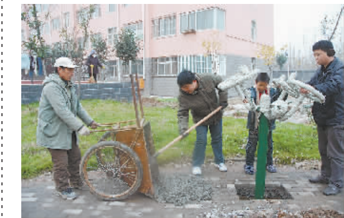
12月4日,市房管中心焦东房管所工作人员在民馨苑小区安装健身器材。 王晶晶 摄
