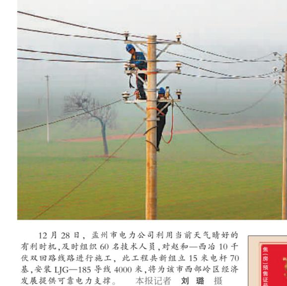
12月28日,孟州市电力公司利用当前天气晴好的有利时机,及时组织60名技术人员,对赵和一西冶10千伏双回路线路进行施工,此工程共新组立15米电杆70基,安装LJG-185导线4000米,将为该市西部岭区经济发展提供可靠电力支撑。 本报记者 刘璐 摄
