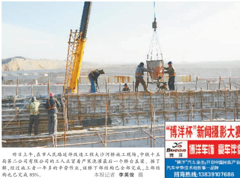
昨日上午,在市民路延伸改造工程大沙河桥施工现场,中铁十五局第二分公司有限公司的工人正冒着严寒浇灌最后一个桥台盖梁。据了解,经过施工者一年多的辛苦作业,该桥下部结构已全部完成,上部结构也已完成 85%。 本报记者 李英俊 摄
