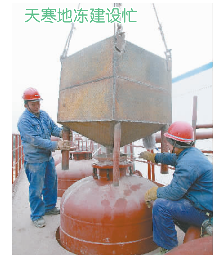
目前，合晶科技二期工程后续氯碱纯化项目正在紧张施工。据悉，该项目建成后，可对开元化工的富余氯碱废气吸附纯化，每年为企业创造效益 3540 万元。图为 1 月 5 日该公司员工正在装填料。 孔小海 摄
