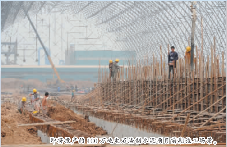
即将投产的100万吨电石渣制水泥项目前期施工场景。
