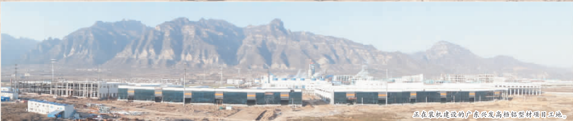
正在紧锣密鼓建设的广东兴发高纯铝型材项目工地。
