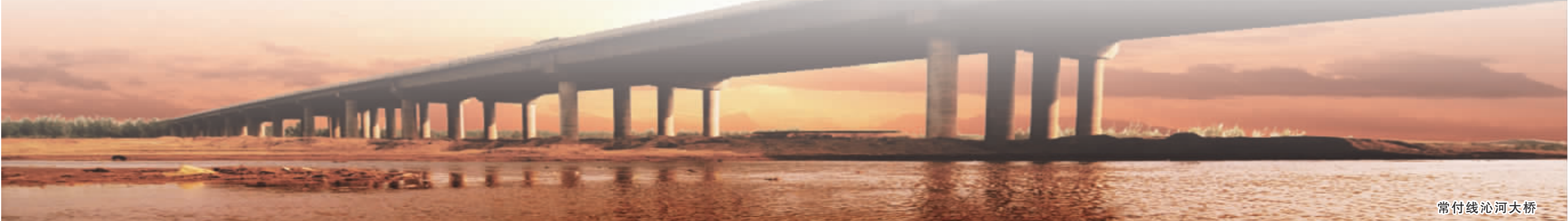
常付线沁河大桥
