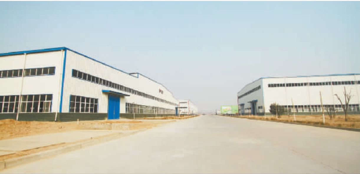
河南福沃重工工业园总投资11亿元,年产500台热模锻压力机、电动螺旋压力机等重型装备。
