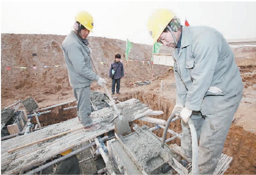
新春伊始，焦作供电公司组织力量，全面加快南水北调工程电力设施建设进度。图为近日该公司员工正在浇筑电力线路铁塔基础。
