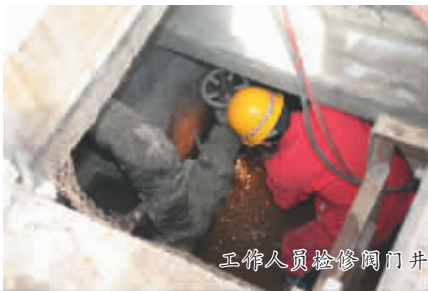
工作人员检修阀门井
