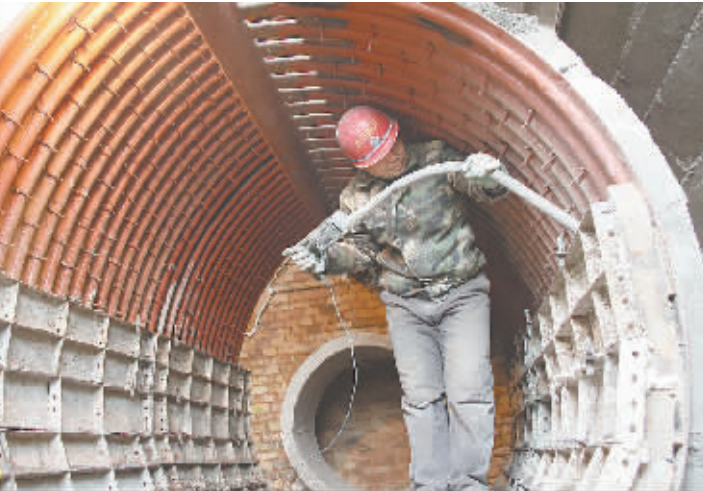
方庄二矿抓节能环保降耗,广泛应用新技术、新设备,逐步淘汰高耗能低能的设备,达到节能减排的效果。图为该矿投入380余万元的10吨硫化床锅炉正在安装中。
