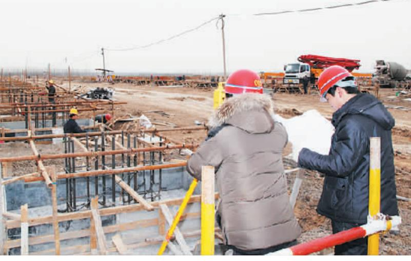
3月6日,奇瑞汽车焦作发动机项目工地一派繁忙景象,近处监理方在对厂房基础地脚螺栓进行定位测量,远处项目进行混凝土浇灌和土方回填作业。为确保在今年10月1日第一台发动机生产下线,该项目自2月1日开工奠基以来,科学调度、倒排工期、加班加点、全力推进,仅用一个月时间就完成投资6500余万元。刘昆摄
