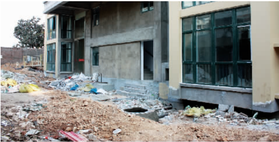
墙体外立面尚未粉刷完毕,道路上满是建筑垃圾。
