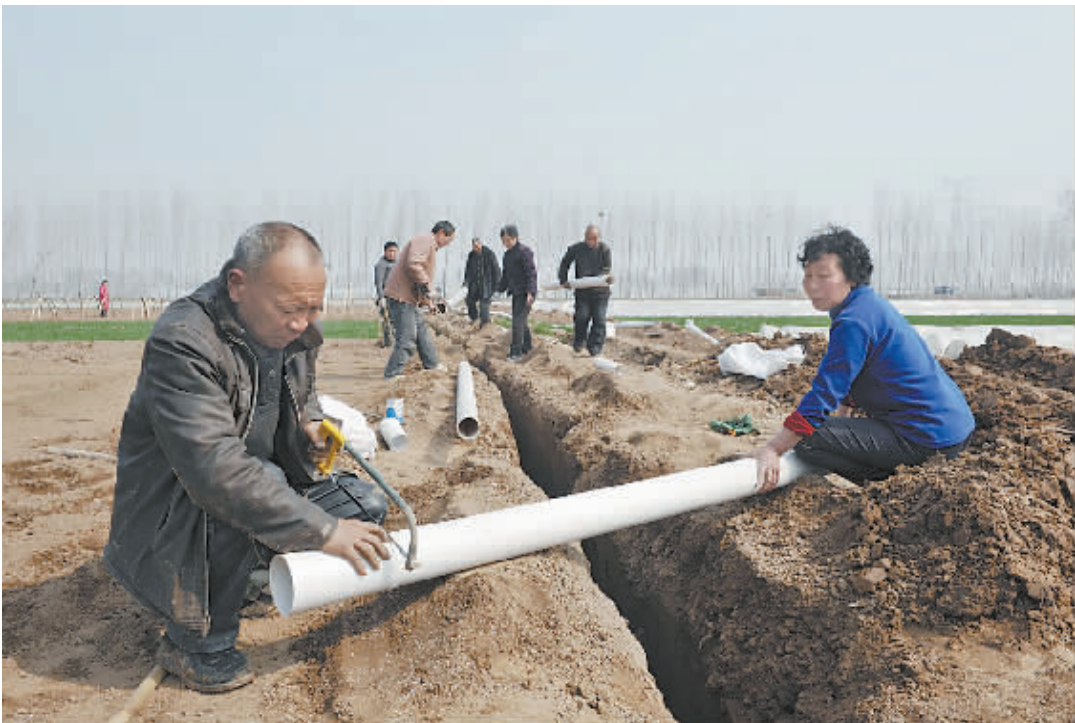
去冬今春，博爱县投资3629.81万元启动小型农田水利建设工程，建设高效节水灌溉工程2.97万亩。该工程完工后，可平均新增粮食生产能力150万公斤，节约农业灌溉用水735.75万立方米。这是在博爱县孝敬镇徐庄村的农田里，村民们正在敷设节水地理管道。
