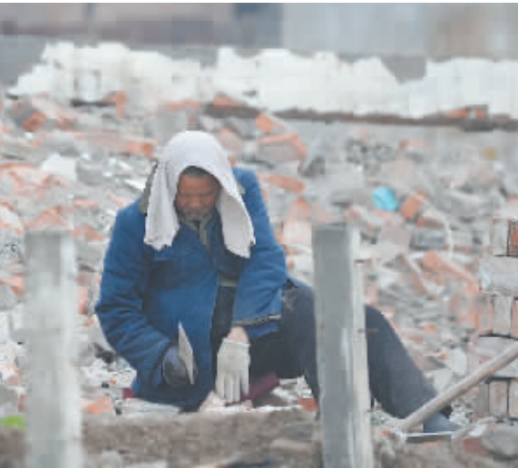
↑一位老大爷正在清理自家的拆迁垃圾。
