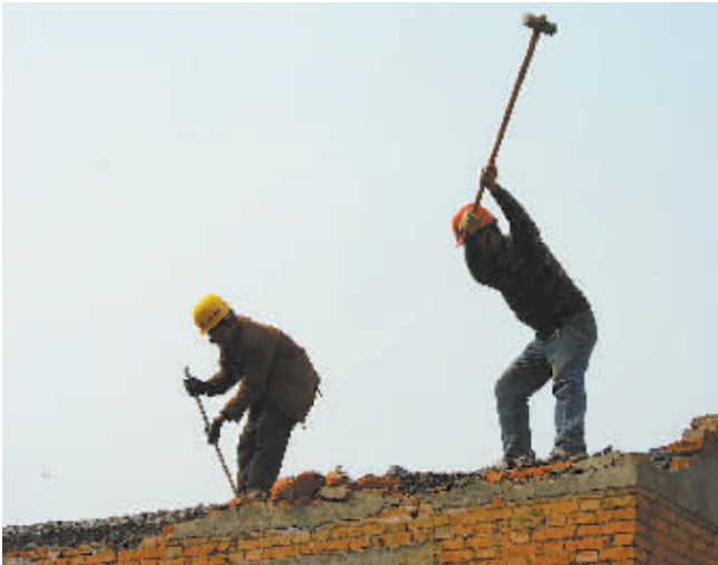
↑恩村三街组织人力抓紧拆除拆迁房屋。
