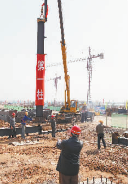
奇瑞汽车焦作发动机生产基地第一根钢柱起吊安装现场。 本报记者 付凯明 摄
