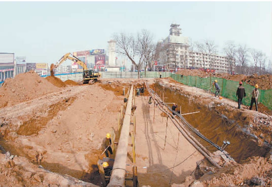
3月25日,市东方红广场人防过街通道项目正在紧张施工。据了解,该项目附近为居民生活区,道路地下管线较多,为保护地下管线不破坏,维持居民正常工作与生活,部分工程将采用盖挖法(即逆作法)进行施工。截至目前,该项目土方开挖已完成60%,预计5月10日恢复道路通行。
