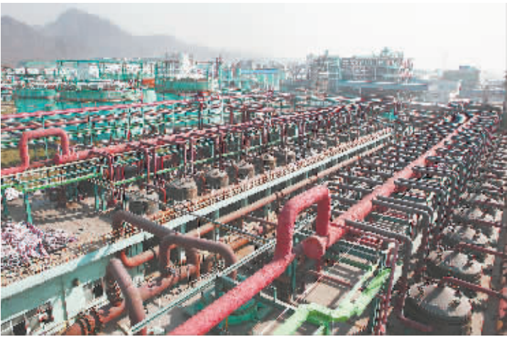
↑中国吴华焦作沁北工业园二期工程位于沁阳市沁北产业集聚区,该集聚区是河南省首批重点产业集聚区之一。
