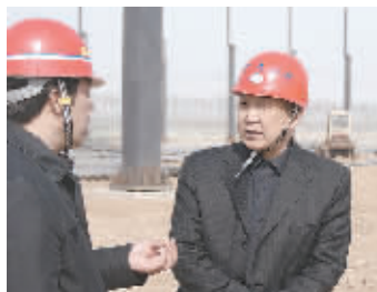
庞长鸿（右）在工地检查施工质量。崔荣杰 摄
