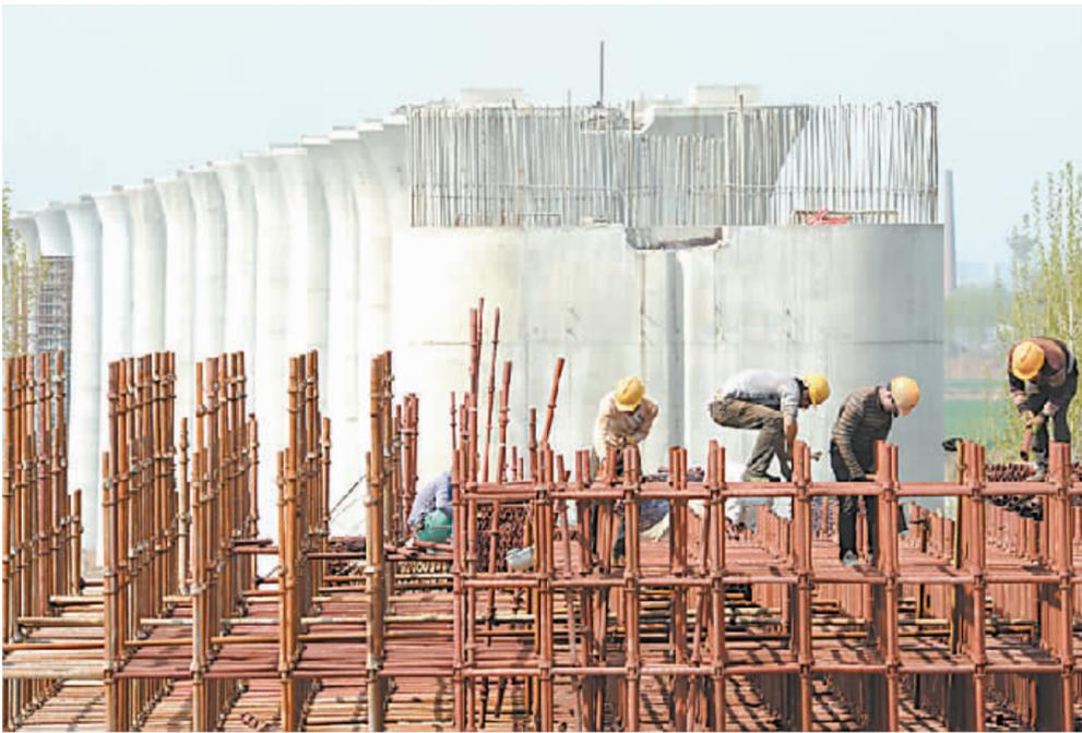
昨日中午,工人们在郑焦城际铁路跨新月铁路特大桥工地紧张施工。据悉,该桥全长2.8公里,2010年9月开工建设,目前下部结构桩基已全部完成,桥墩完成72个,占总工程量的90%。
