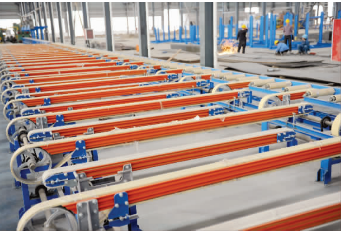
4月16日，广东兴发铝业（河南）有限公司10万吨高档铝型材深加工项目工地，工人们正在安装设备。该项目主要从事高档铝型材精深加工，分两期建设，项目全部投产后年可实现产值20亿元，利税2亿元。李亚锋 摄
