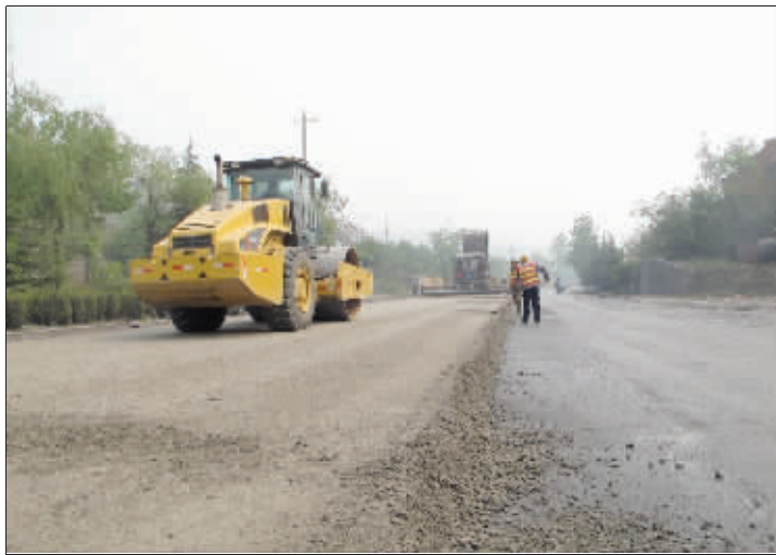
卫栎线沁博交界至廉坡段大修工程于3月下旬开工建设，该段全长2.198公里，采用二级公路标准进行大修，路基按原有宽度不变，路面面层采用沥青混凝土结构，工程预计5月底可结束。目前，该工程正在进行水泥碎石基层铺设。 王利华 张玉兵 摄
