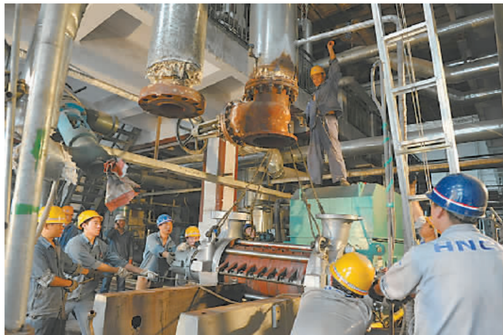
为应对即将到来的夏季用电高峰,焦煤集团冯营电力公司近日组织人员抢抓有利时机对设备进行检修,消除设备隐患,确保机组安全稳定运行。因为技术人员正在对设备进行检修。 夏彬彬 摄
