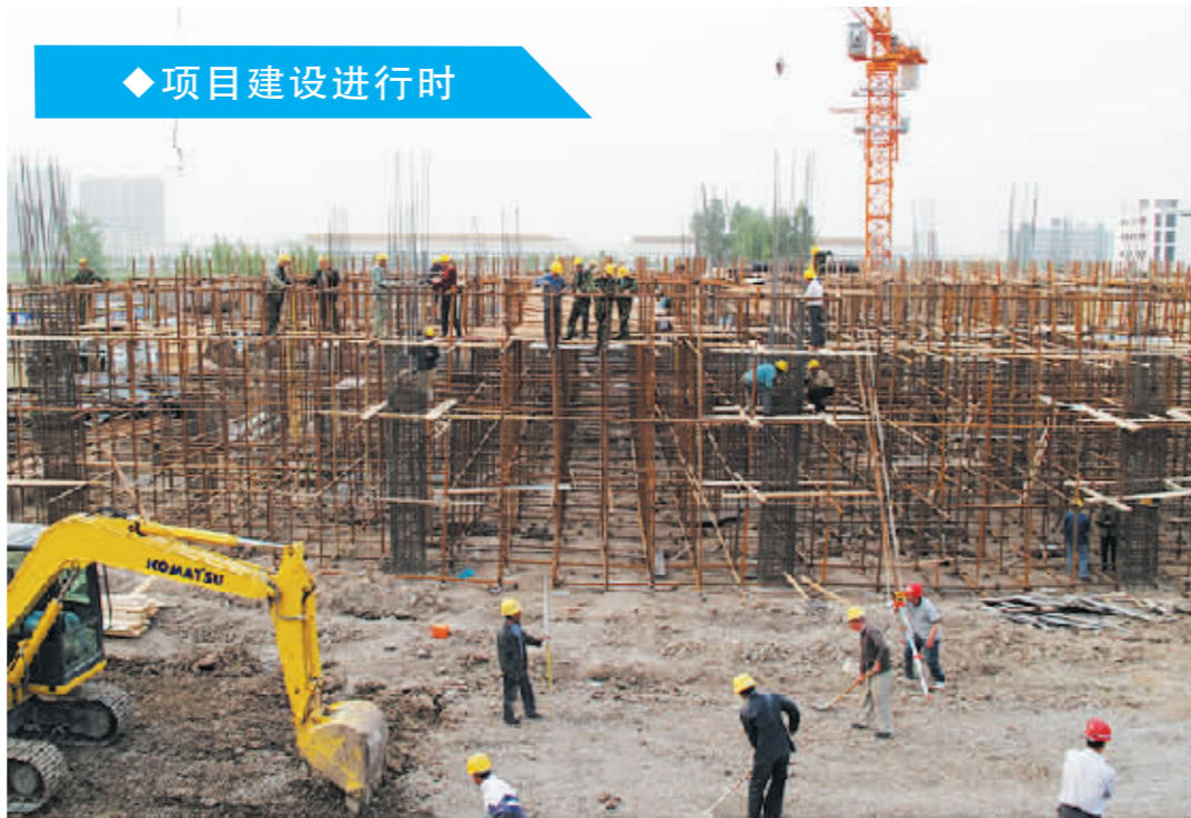
近日,承建新区标准化厂房建设的葛洲坝集团第六工程有限公司开展了“大干快上、紧追快赶”春季劳动竞赛,工人师傅们放弃五一小长假休息机会,坚守在项目工地一线,干劲十足地进行建设“比武”。图为工人们正在2号厂房主体工程工地忙碌。刘昆摄
