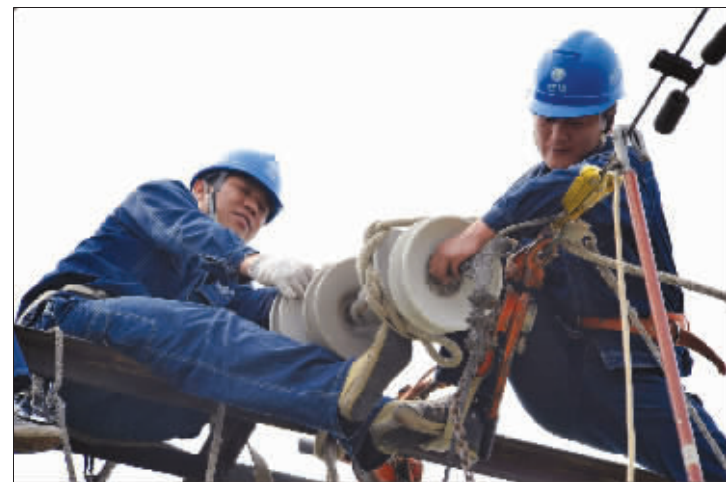
为确保输电线路迎峰度夏安全稳定运行,5月2日,市电业局组织20余名技术人员,对辖区部分输电线路老化绝缘子进行更换,确保输电设备保持良好运行状态,为迎峰度夏打好坚实基础。图为该局输电部工作人员正在对35千伏沁和线绝缘子进行更换。李海洲 杨向军 摄
