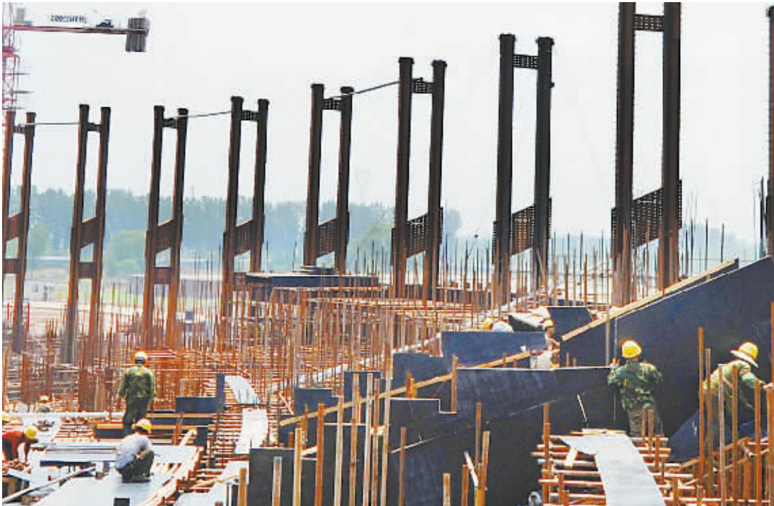
昨日上午，记者在焦作国际太极拳文化交流中心暨全民健身中心项目体育场建筑工地看到，一个巨大的圆形体育场已初具雏形，来自河南红旗渠集团有限公司的工人正热火朝天天地施工。据悉，由于该公司科学安排、精心施工，截至目前，该体育场主体已施工至一层顶板，一层钢筋混凝土和模板已完成40%，钢骨柱二节柱已安装完毕，水电安装也在同步进行。
