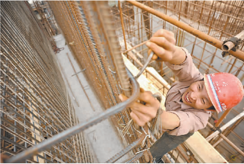
昨日上午,建设者正在南水北调焦作问河倒虹吸工程出水段捆绑钢筋。该工程横跨市塔南路,总造价约2.76亿元,长441米,由进口渐变段、进口检修间、管身段、出口控制间和出口渐变段5部分组成。目前,工程建设已进入收尾阶段,塔南路月底有望恢复正常通车。 本报记者 田建明 摄
