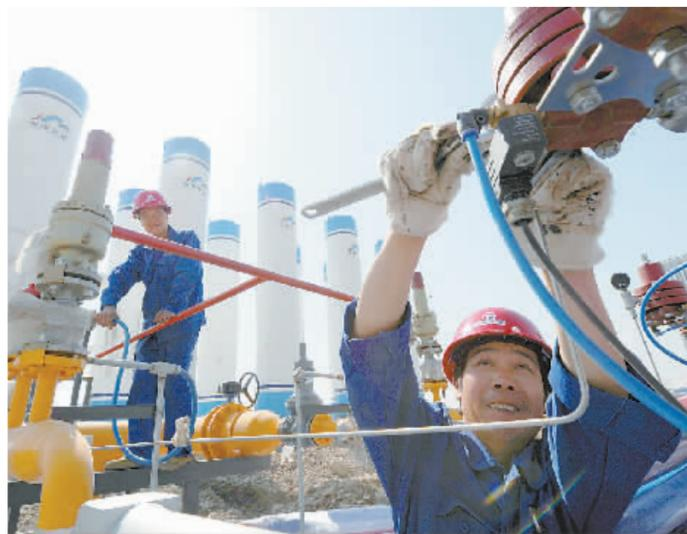
5月17日，河南晋煤天庆煤化工天然气项目工地，技术人员正在安装CNG燃气减压瓶。目前，该项目已经安装过半，将于6月底先期建成，建成后每天可为沁北产业集聚区提供48万立方米的燃气。
