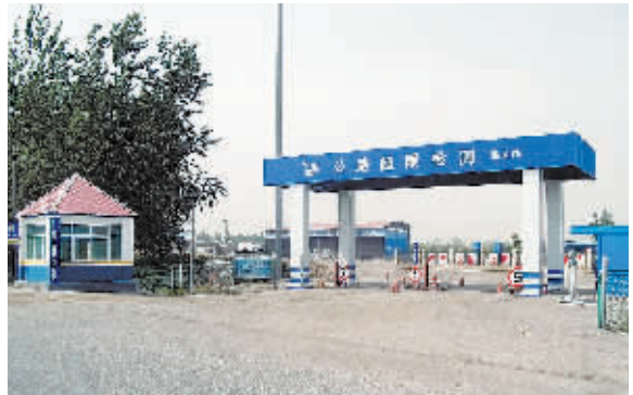
温县黄河桥超限检测站
