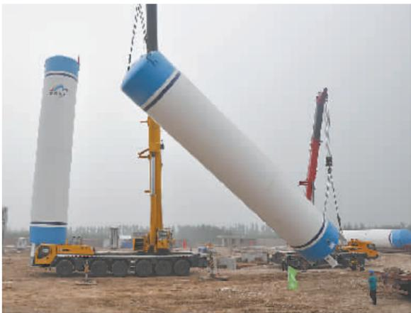
日前，位于沁阳市沁北产业集聚区的省重点项目晋煤天庆公司燃气项目12台液化天然气储罐吊装成功。这标志着天庆公司燃气项目进入设备安装阶段。 石坚 摄
