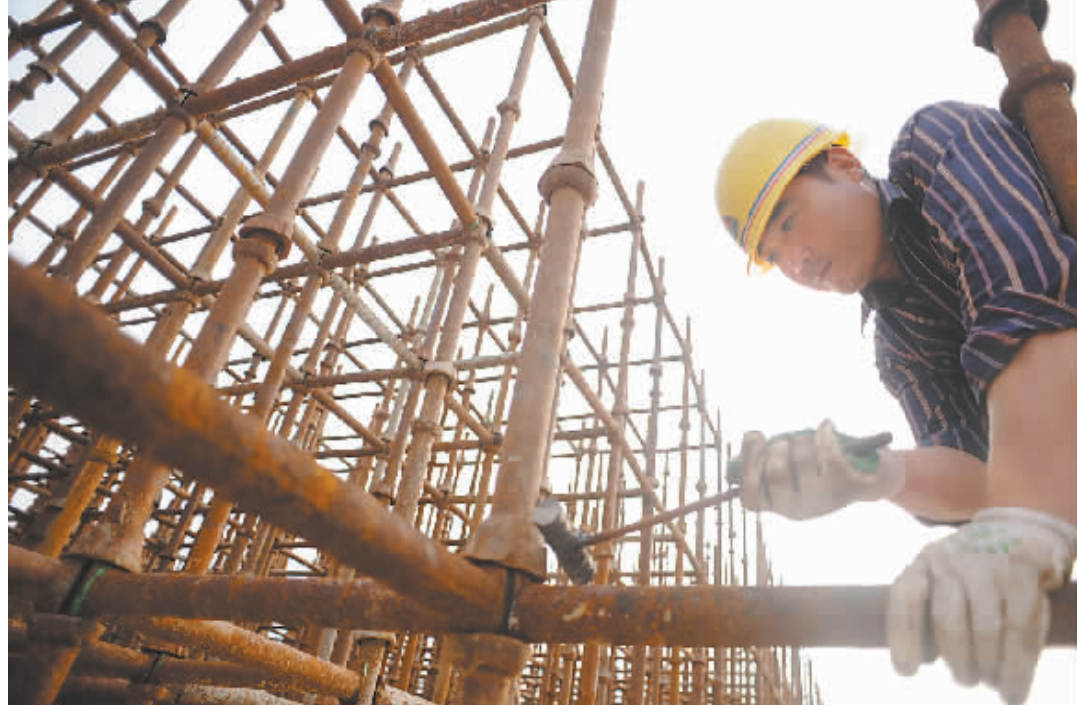
昨日下午，建设者正在南水北调中线工程焦作1段焦东路跨渠桥梁紧张施工。针对跨渠桥梁的复杂性和特殊性，施工单位制订科学合理的进度计划，浇筑班组多班作业，24小时连续施工，目前主桥已完成50%工程量，引桥正在搭建模板钢筋，预计今年8月底可顺利通车。 本报记者 田建明 摄
