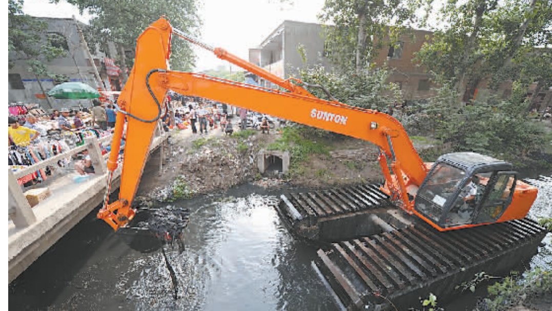
5月24日,大型挖泥船在普济河西王褚村段清理河道。为确保我市城区河道和南水北调城区段安全度汛,确保在5月31日前完成普济河、群英河、瓮河以及李河等四条河流域段清淤工程,市水利局租用一台大型挖泥船对难度较大的普济河城区段进行清淤,这也是我市在城区段清淤工程中首次使用挖泥船,与人工和普通机械清淤相比,工效可提高10倍以上。 本报记者 杨帆 摄
