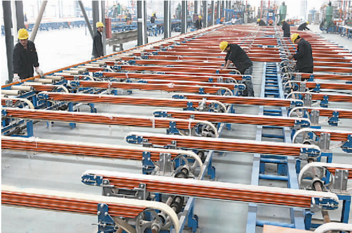
6月9日,位于沁阳沁北产业集聚区的广东兴发铝业(河南)有限公司员工正在安装棚架冷却台,为即将投产的年产10万吨高档铝型材项目作最后准备。据了解,该项目总投资10亿元,达产后年可实现产值20亿元,利税2亿元。
