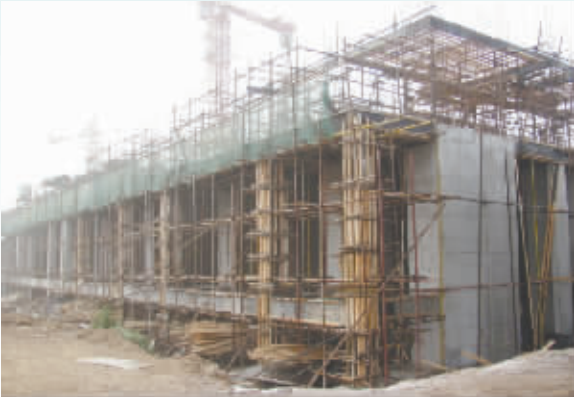
南庄镇以新型农村社区建设为重点,全面推进城镇化进程。图为南庄镇骑马庄新型社区项目正在加紧施工。 孟南摄
