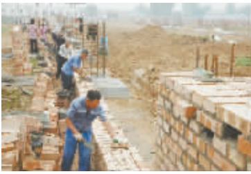
正在建设的德众保税中心。
