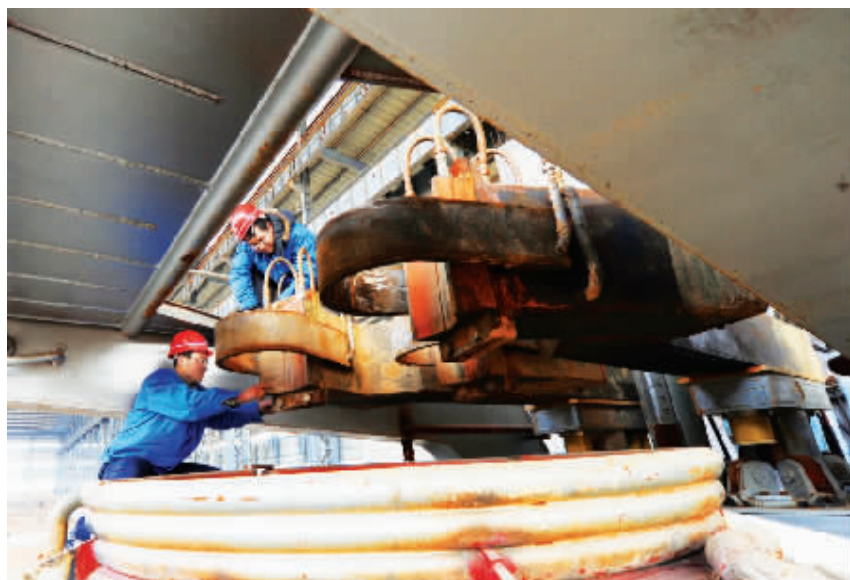
河南福沃重工有限公司福沃重工工业园项目建设工地，技术人员正在安装调试特大电弧炉。
