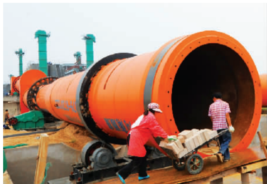
投资7.5亿元的河南顺康能源新材料有限公司年产20万立方米石油支撑剂项目建设如火如荼。
