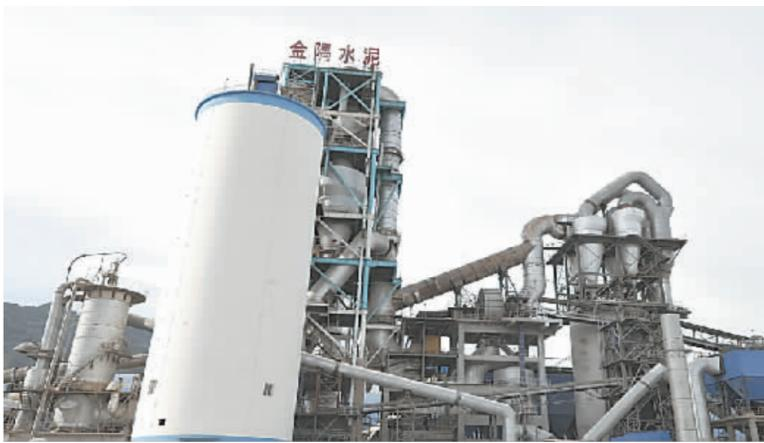
这是记者6月14日拍摄的沁阳市金隅水泥公司电石渣制水泥项目生产线。沁阳市金隅水泥公司总投资5亿元的电石渣制水泥项目经过近半年的试生产,运行状况平稳,目前日产量超过2000吨,产品顺利投放市场。据介绍,该项目是全省最大的电石渣制水泥项目,每年可消化掉113万吨电石生产过程中排出的电石废渣。
