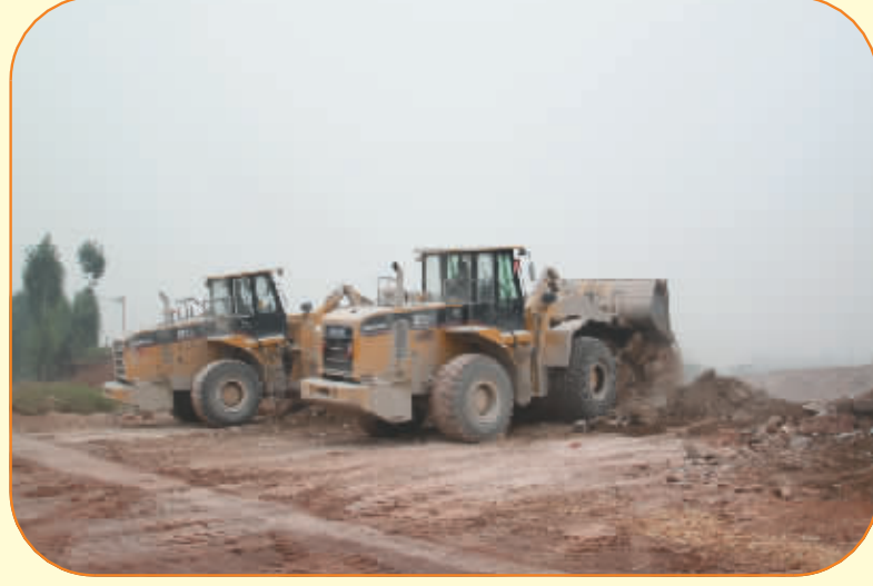
北山地质环境治理项目施工现场。
