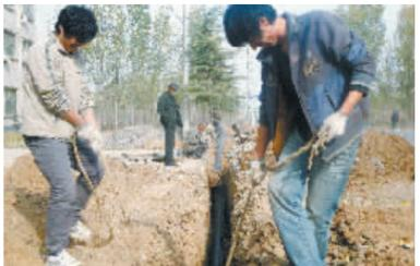
图为施工工人正在进行农村饮水安全管网安装。 贾长灵 摄
