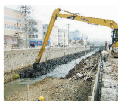
幸福河治理工程是博爱县今年汛期前确定的营造城区生态水景观、防洪除涝等重点工程。该工程主要建设内容包括河道清淤扩宽3800米,建设挡水建筑物11座,修建雨污分离管径8000米及两个绿化3万平方米等。图为大型施工机械正在进行河道清淤扩宽施工。本报记者 原文钊 本报通讯员 张超 摄
