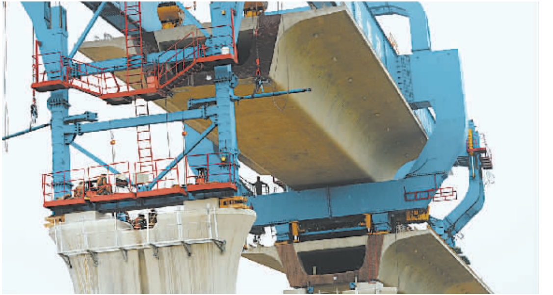
昨日上午，记者在郑焦城际铁路跨新月第二双线特大桥施工现场看到，施工人员正冒雨架设箱梁。据悉，该箱梁长 32 米，单片重 714.8 吨，跨度 31.5 米，盆式橡胶支座，采用 JQ900A 型架桥机架设，从焦作往郑州方向进行，总数为 77 片，目前正在架设第九片，预计 9 月中旬完工。
